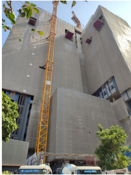
ภาพที่ 5-28 ปิดคลุมอาคารด้วยผ้าใบกันไฟลามอย่างมิดชิดทุกชั้นความสูงอาคาร และติดตั้งทาวเวอร์โครน
