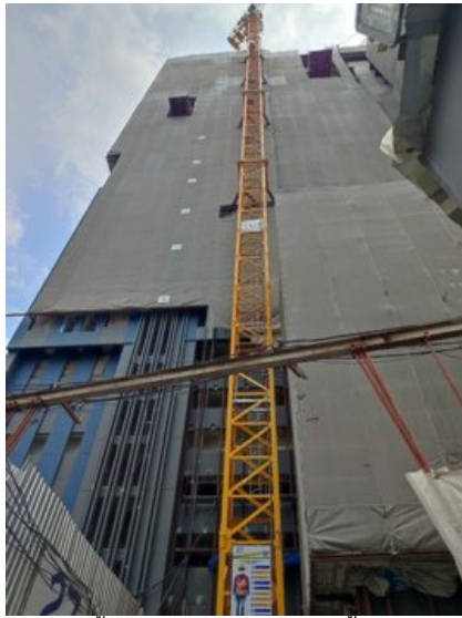
ภาพที่ 5-28 ปิดคลุมอาคารด้วยผ้าใบกันไฟลามอย่างมิดชิดทุกชั้นความสูงอาคาร และติดตั้งทาวเวอร์โครน
