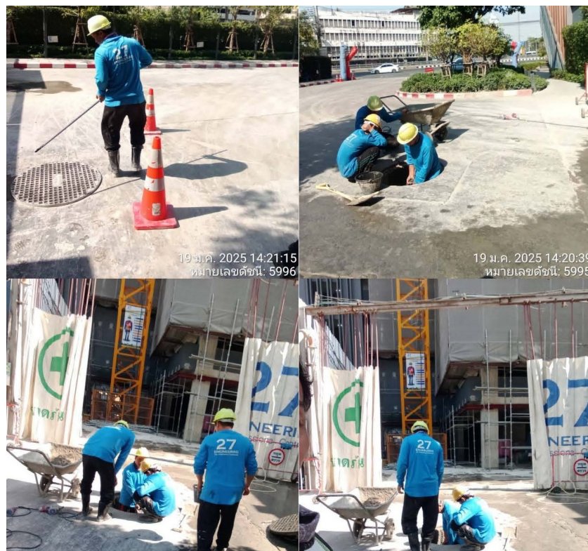
ภาพที่ 5-21 ขุดลอกท่อระบายน้ำหลังจากการเสาะเข็มแล้วเสร็จ
