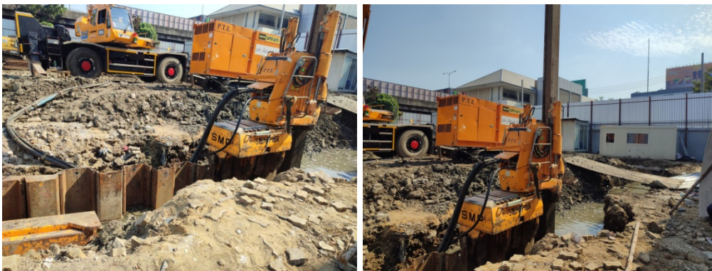
ภาพที่ 5-12 ทำเสาเข็มแบบเจาะ ชนิดเบี่ยง และกด Sheet Pile
